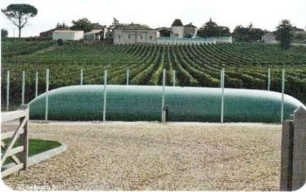
La mise en œuvre de ce type d'installation est simple : une cuve de récupération dimensionnée par rapport à vos besoins et votre potentiel, reliée à un réseau séparé. En moyenne, on estime qu'en Champagne, pour une surface de 100 m<sup>2</sup>, une cuve de 5 m<sup>3</sup> est suffisante pour couvrir les besoins de l'ordre de 50 m<sup>3</sup>/an [source : guide pratique de la Construction durable en Champagne, 2012].
